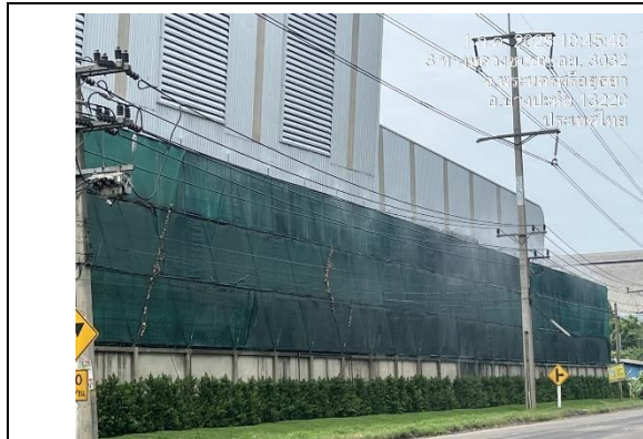
สแลนป้องกันฝุ่นและระบบสเปรย์น้ำบริเวณด้านหน้าของโครงการ
